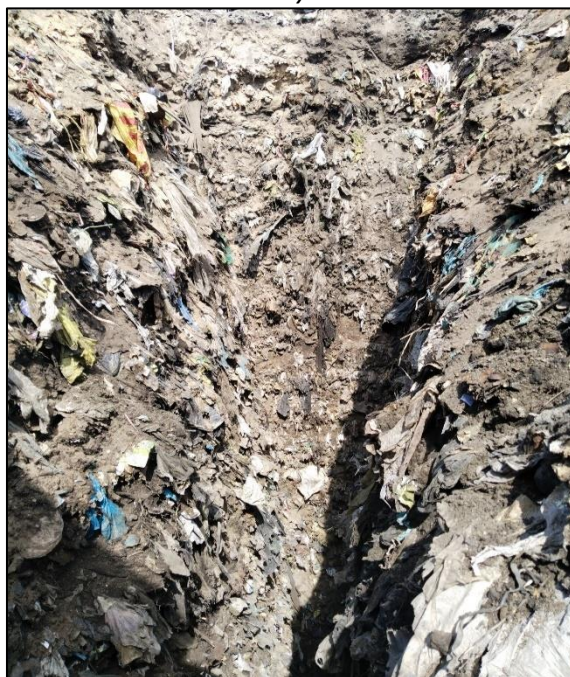
Imagen 6 Excavación en zonas de mayor acumulación de Residuos Solidos
